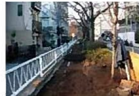
2.歩道部分にパワーミックスを施工。
