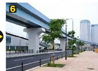
植栽およびインターロッキングブロックを施工して完成。
