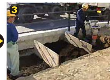
根系伸長域にパワーミックスを一層20cm厚みで投入し、振動プレートにて転圧を加える。
