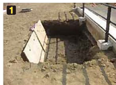
路床部分に生育用基板樹を掘る。
