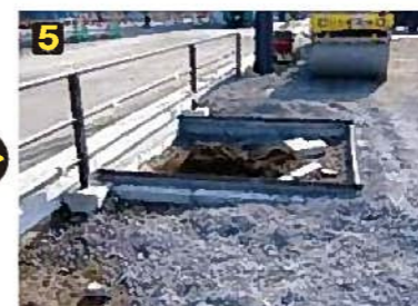
緑化基盤と外枠を施工して、路盤(RC)を転圧。
