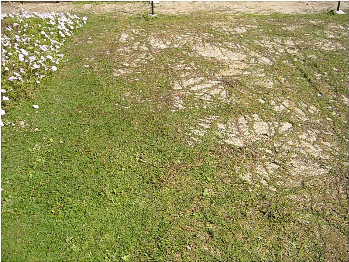
クラピア施工区
