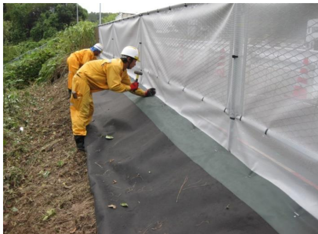
U型アンカーピン(φ 4×250mm)を打設
