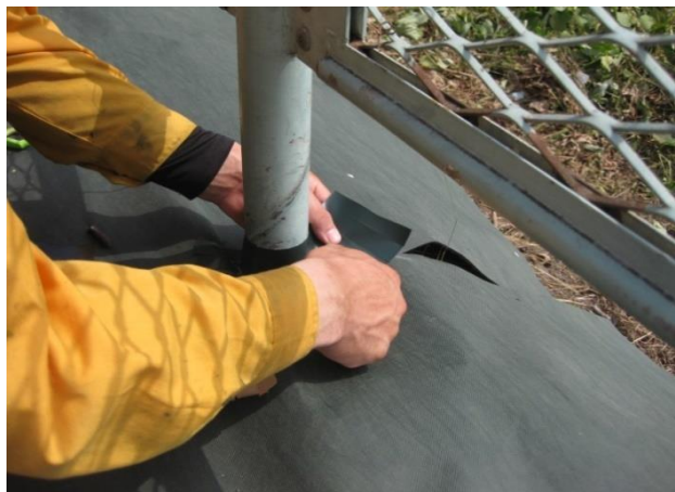
つるガードネット(H1. 5m)を設置・シートとネットを接着
