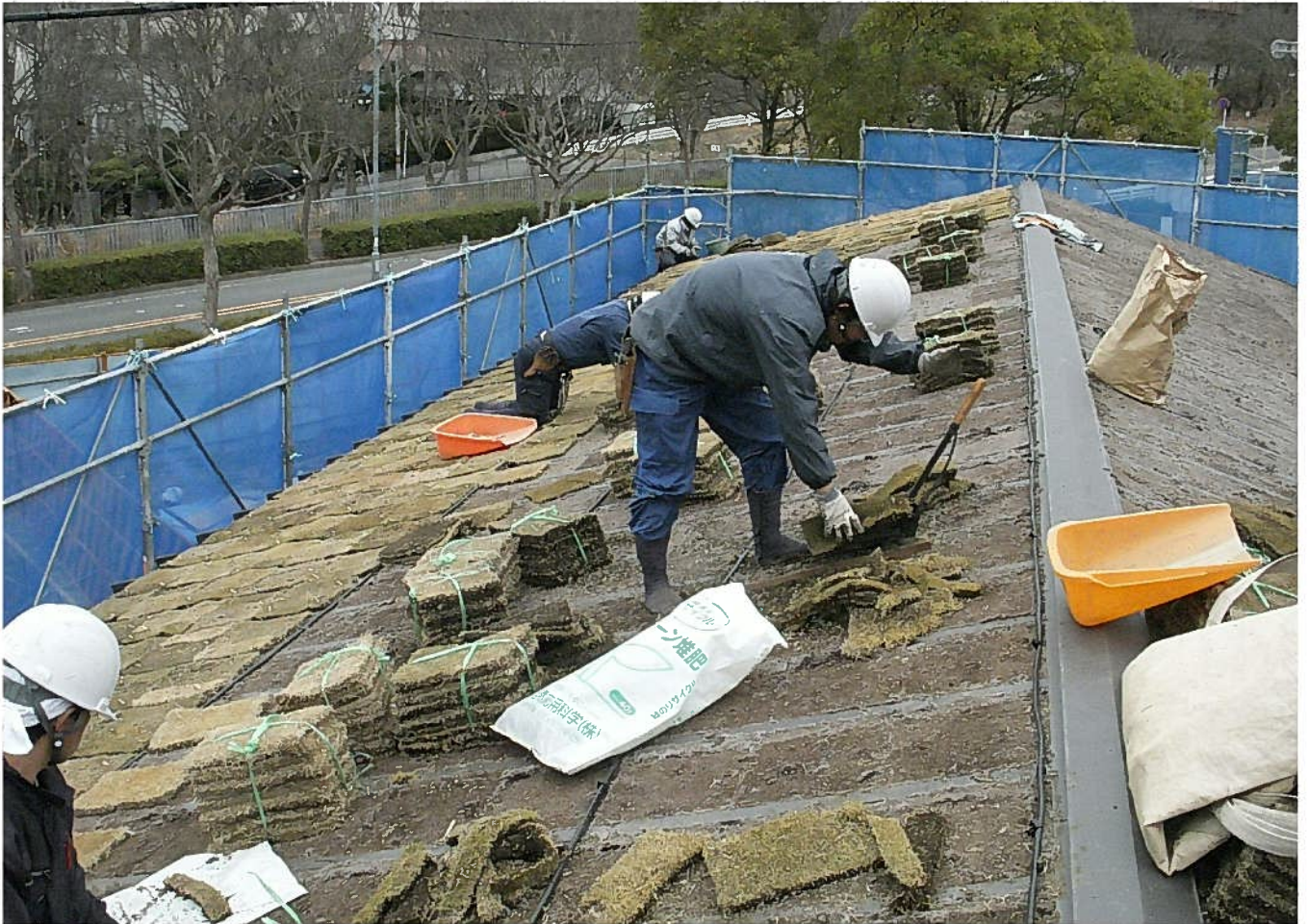
コウライシバ施工状況（自動灌水あり）
