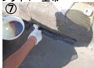
プライマー塗布
