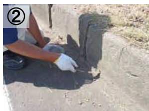
抜根除草・目地堆積物の処理
