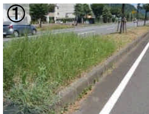
施工前の状態
