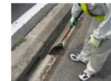
3. 路面の清掃(接着不良の要因となる砂埃の除去)
