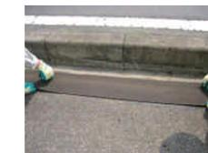
6. 加熱後、路面に貼り付け、特に端部を十分に転圧する。
