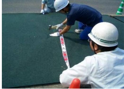
止めピンを用いてシートを固定する。
