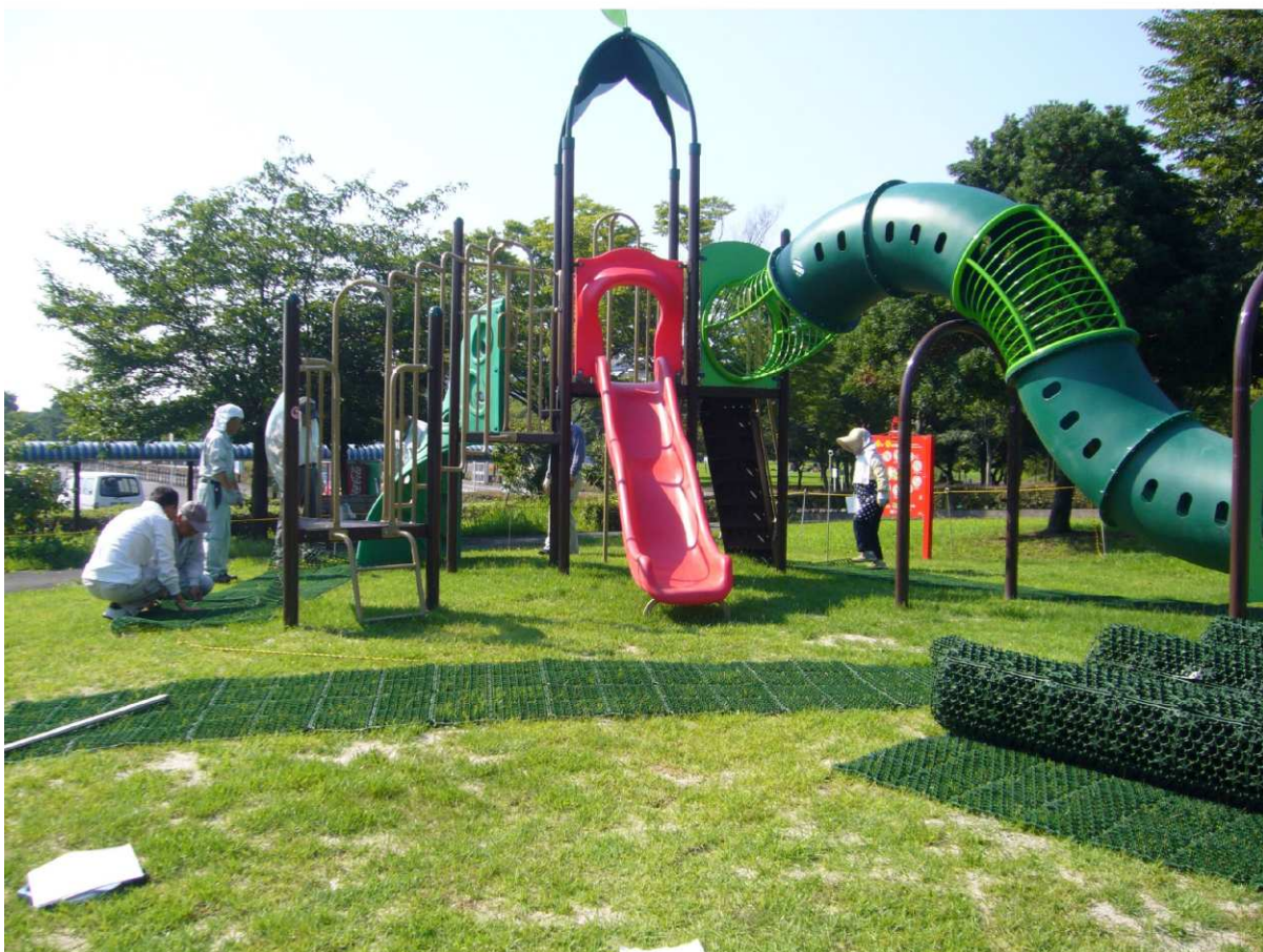
2010 年 7 月 2 2 日 愛知県一宮市光明寺公園 施工中
