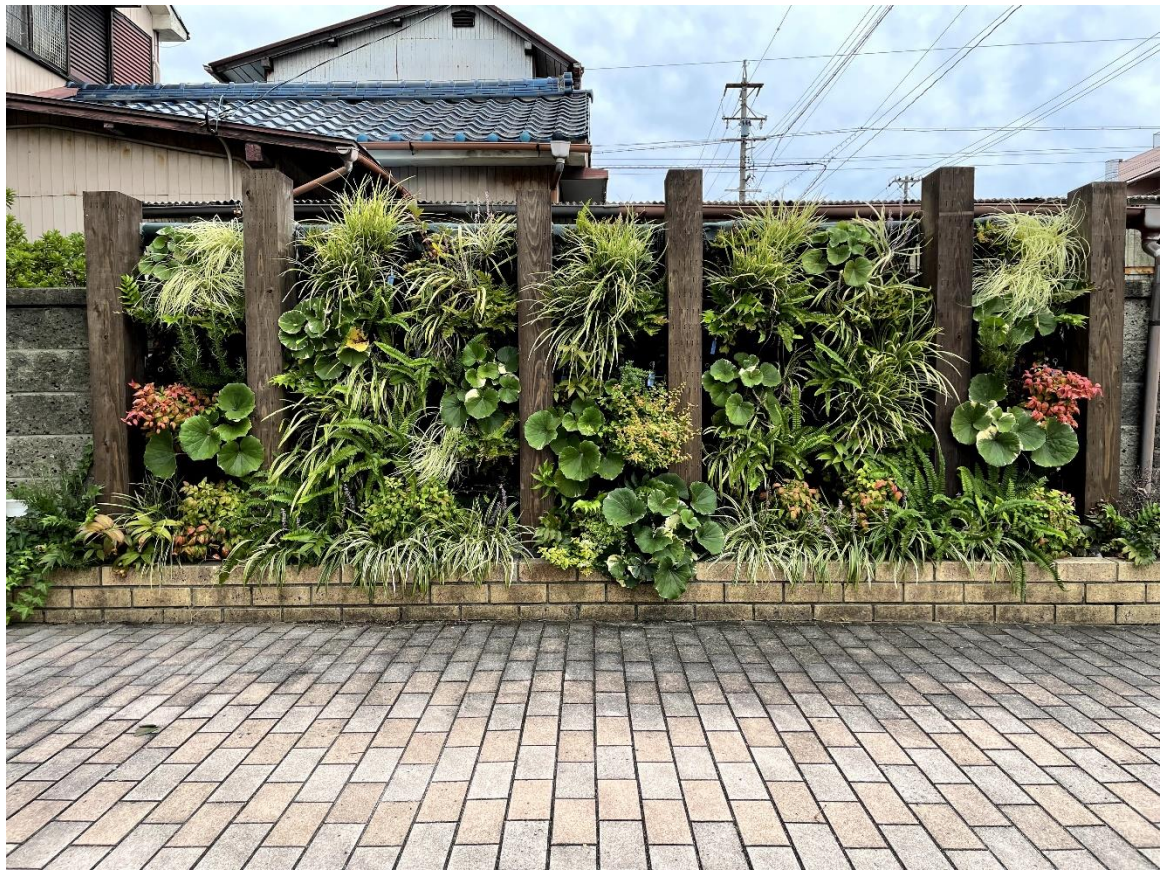
2021 年 10 月 1 日 施工後 6 カ月
